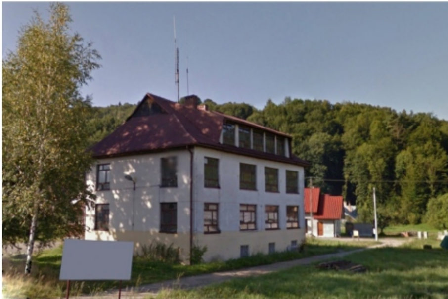
GOK - studio na I piętrze oraz anteny na dachu
